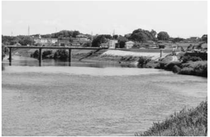
現在本築堤工事中の上ノ橋付近
