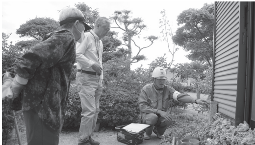
水道の点検をする社員
