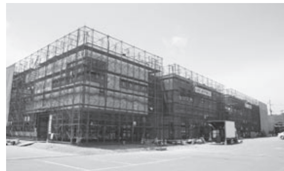
▲(仮称)複合施設(本宮字千代田地内)
