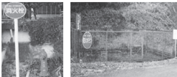
▲消火栓(左)と防火水槽(右)
