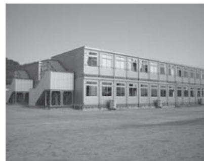
▲昨年7月に完成した仮設校舎
