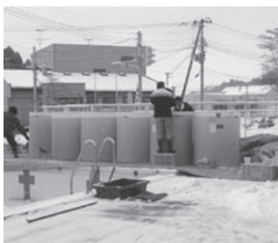
白岩小学校プール除染作業のようす
