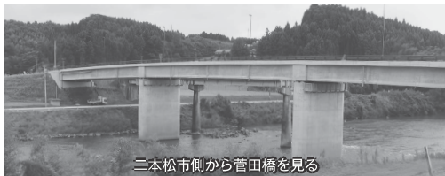
二本松市側から菅田橋を見る
