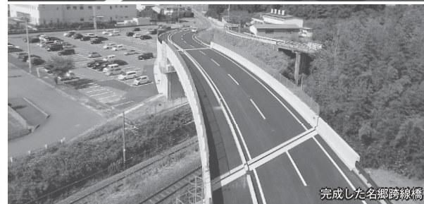
完成した名郷跨線橋
