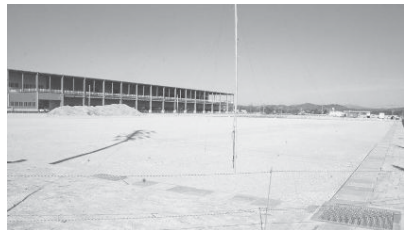
ほぼ完成となった荒井の本宮市工業等団地第6工区
