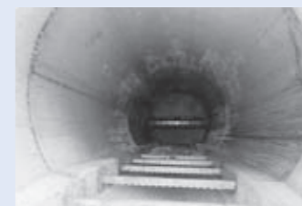
良好なマンホールの状態
