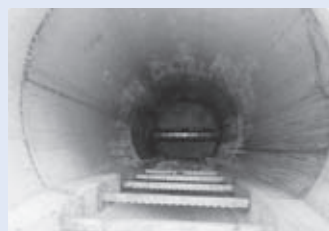
良好なマンホールの状態
