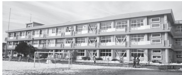
▲五百川小学校校舎耐震化工事
