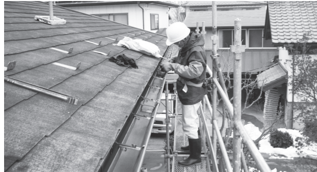
▲27年度全地区完了を目標に住宅除染を実施
