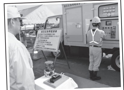
東北電力による電力復旧訓練
