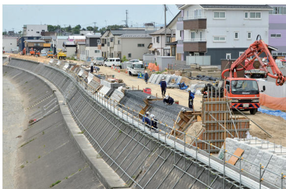
築堤工事が進む中条地区
