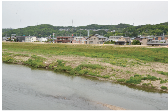
樹木伐採が完了した高木地区
