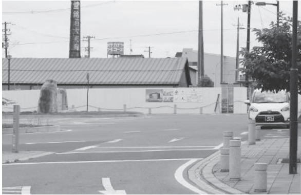
▲現在工事中の(仮称)地域交流センター
