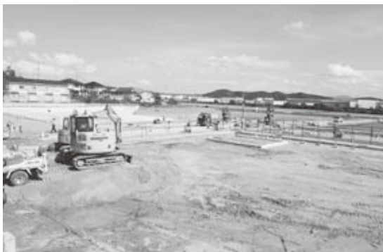
▲本宮第二中学校グラウンド拡張造成工事の様子 (荒井字団子森地内)
