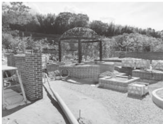
▲建設中の英国庭園 (プリンス・ウィリアムズ・パーク)
