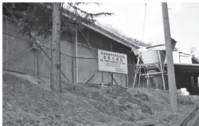
操業に支障をきしている本宮市堆肥センター
