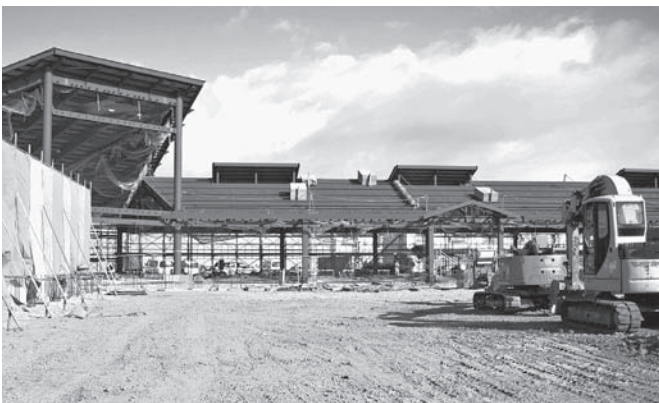
建設中の幼保総合施設
