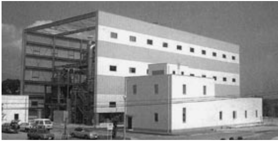
下水汚泥溶融施設（県中浄化センター内）
