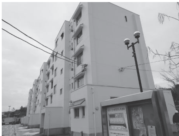
▲定住促進住宅として活用する雇用促進住宅しらかわ宿舎（糠沢字小田部地内）
