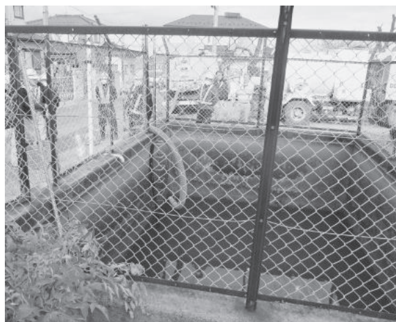
▲防火水槽除染現場（本宮字霞ヶ入地内）
