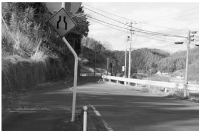
狭く危険な主要地方道
