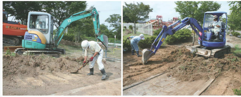
写真左は本宮字兼谷平地内の公園、写真右は糠沢字光が丘地内の公園の除染作業の様子。それぞれ重機と手作業により表土を除去して地下に埋設しました
