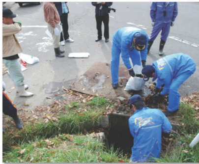
(写真上右) 高圧洗浄機を使用して道路の除染作業を行う本宮12区町内会の皆さん (写真上左) 線量低減化事業により発生した土砂を一時保管場所に埋設する羽瀬石町内会の皆さん (写真下左) 柵の堆積物を除去し、土のうに詰める糠沢6区の皆さん
