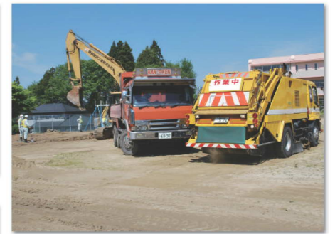
(写真右) 和田小学校の除染の様子。ロードスイーパーで校庭の表土をかき集める (写真左上) 除染前後の線量を把握するため測定を行いました (写真左下) 学校の表土除去についてマスコミのインタビューを受ける高松市長
