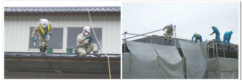
(右) 和田字若木沢地内で住宅モデル除染を実施した(平成24年3月9日撮影) (左) 和田地区の住宅モデル除染で、雨樋の拭き取りを行う作業員(平成24年3月9日撮影)
