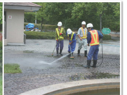
(写真上2枚) みずいる公園のベンチとインターロッキングを高圧洗浄する作業員
