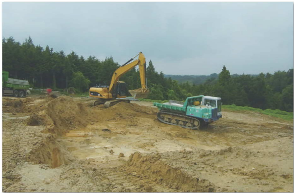
造成工事を進めている長屋地区仮置き場（平成25年8月5日撮影）
