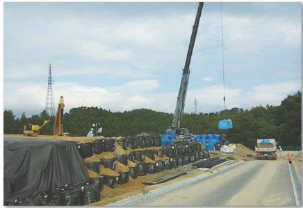
フレコンバッグ搬入している和田地区仮置き場 （平成25年9月3日撮影）
