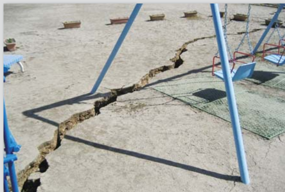
地割れが発生した園庭
