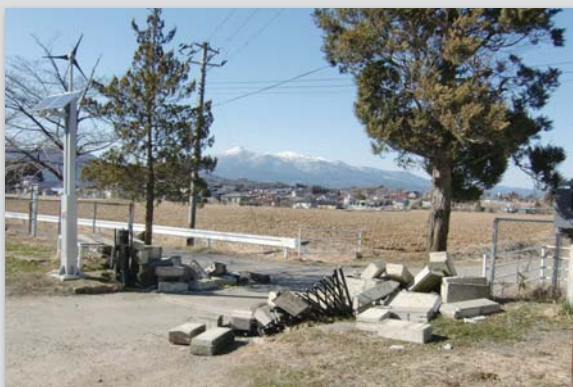
(左上) 震災直後の職員室の様子。書棚が倒れている (右上) 昇降口の下足箱 (左下) 北門入り口の石積が倒壊
