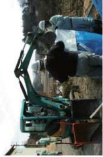
▲和田2区の住宅除染の様子。重機で表土を削いで、フレコンバッグに詰め込んでいきます
