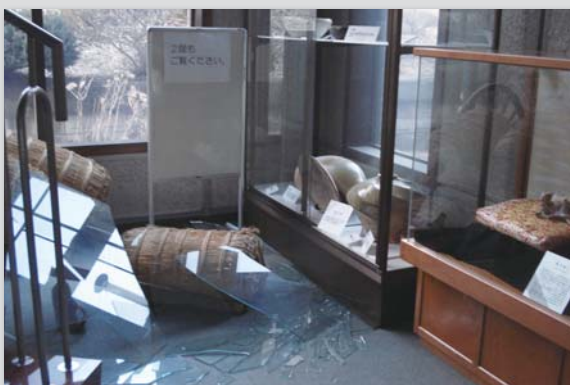
白沢ふれあい文化ホールのショーケース破損
