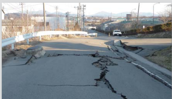
関下字神座地内、市道東原3号線。道路に亀裂が走り、マンホールが隆起
