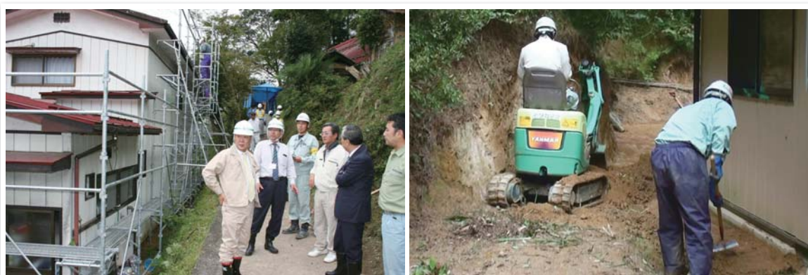
(右) 和田地区の住宅除染の様子。小型の重機や手作業により表土を削り取りました（平成24年9月28日撮影） (左) 住宅除染の様子を視察する高松市長。雨樋の拭き取り作業のため、足場が組まれた住宅（平成24年10月3日撮影）
