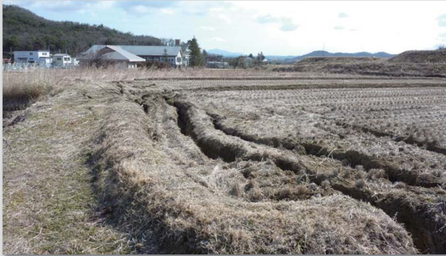
荒井字団子森地内、水田に亀裂
