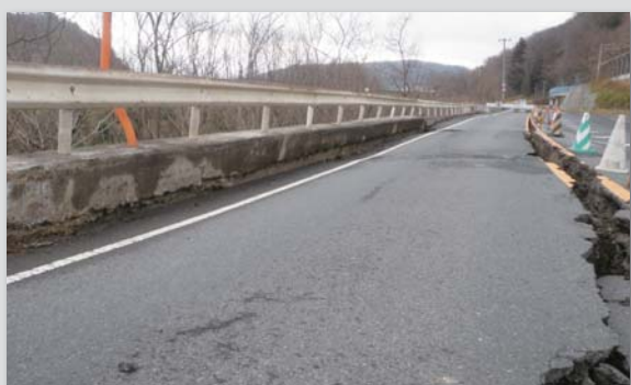
関下字神座地内、市道東原3号線。道路に亀裂が走り、マンホールが隆起
