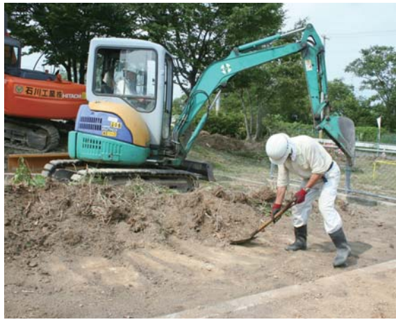
写真左は本宮字兼谷平地内の公園、写真右は糠沢字光が丘地内の公園の除染作業の様子。それぞれ重機と手作業により表土を除去して地下に埋設しました
