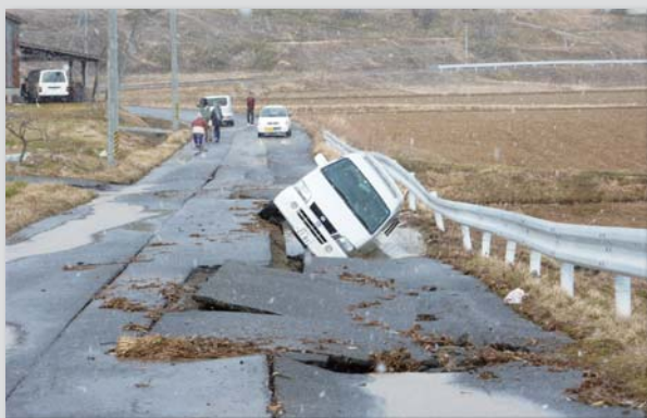
(左) 青田市内市道碓森線。道路が陥没し車が落ちている
