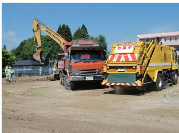
(写真右) 和田小学校の除染の様子。ロードスイーパーで校庭の表土をかき集める (写真左上) 除染前後の線量を把握するため測定を行いました (写真左下) 学校の表土除去についてマスコミのインタビューを受ける高松市長
