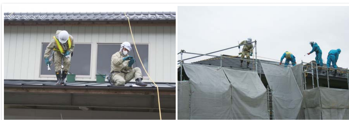
(右) 和田字苦木沢地内で住宅モデル除染を実施した（平成24年3月9日撮影） (左) 和田地区の住宅モデル除染で、雨樋の拭き取りを行う作業員（平成24年3月9日撮影）
