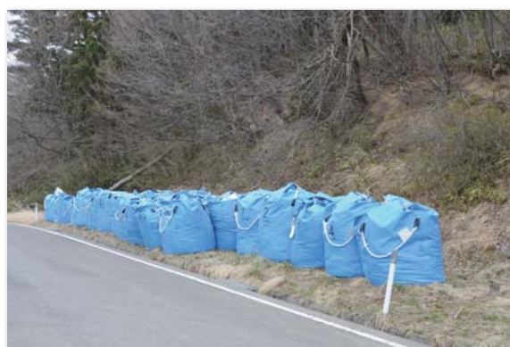
和田地区の住宅除染作業で発生した土砂の入ったフレコンバッグは、仮置き場完成まで一時保管された
