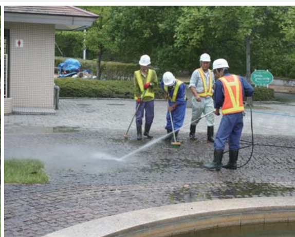
(写真上2枚) みずいろ公園のベンチとインターロッキングを高圧洗浄する作業員
