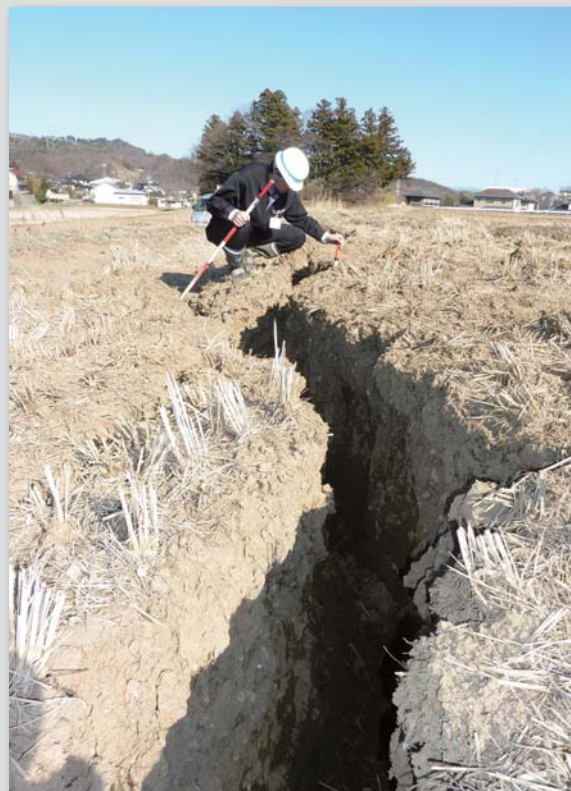
仁井田地内、水田に亀裂
