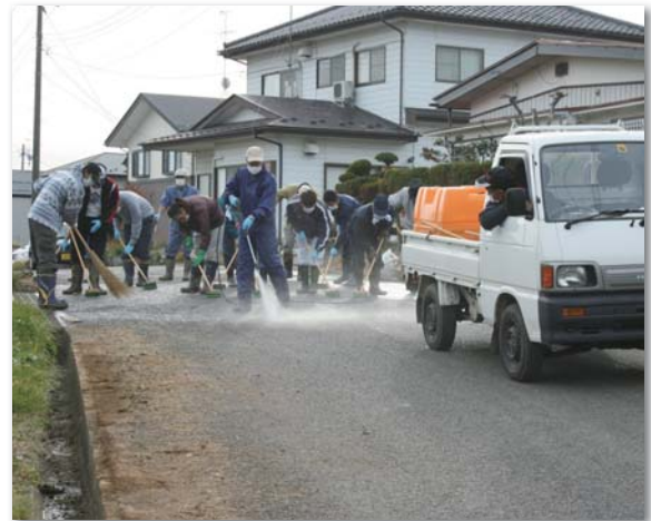
(写真上右) 高圧洗浄機を使用して道路の除染作業を行う本宮12区町内会の皆さん
