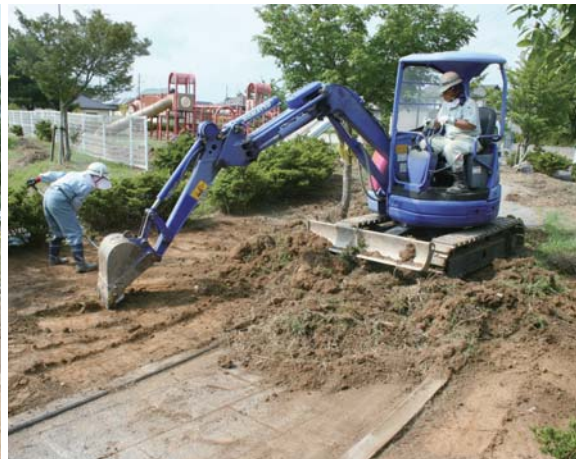
写真左は本宮字兼谷平地内の公園、写真右は糠沢字光が丘地内の公園の除染作業の様子。それぞれ重機と手作業により表土を除去して地下に埋設しました
