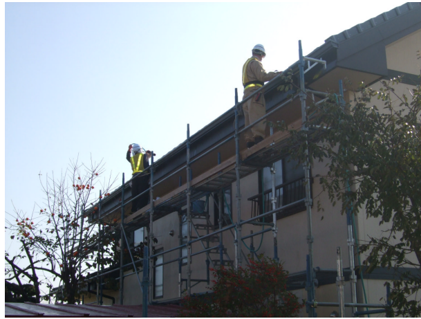
仁井田地区の住宅除染の様子
