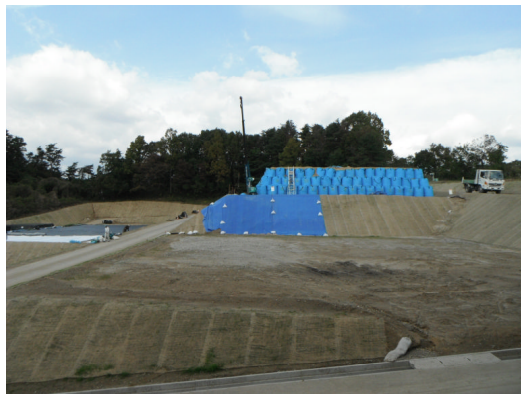
長屋地区の仮置き場の様子
