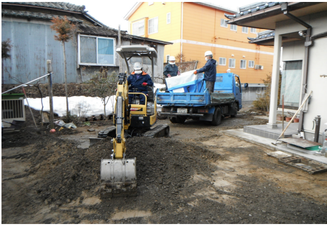
▲庭の表土を重機ではぐ様子
