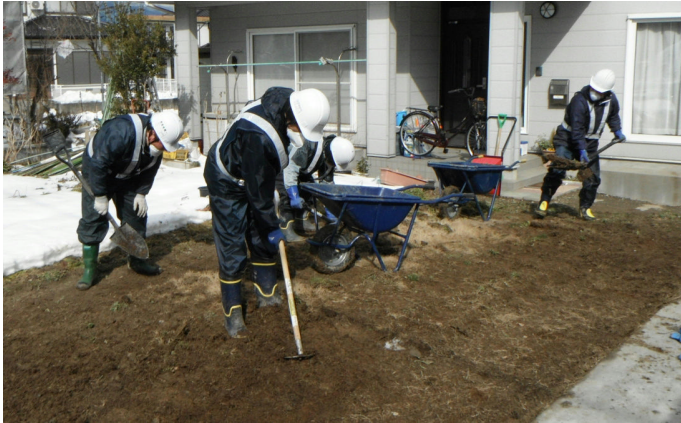
▲作業員の皆さんの手作業により表土をはぐ様子
