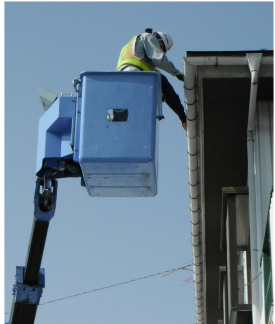
▲高所作業車を使って雨樋を拭き取る様子
