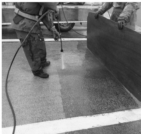
▲荒井地区での住宅除染。舗装路面の高圧洗浄の様子
