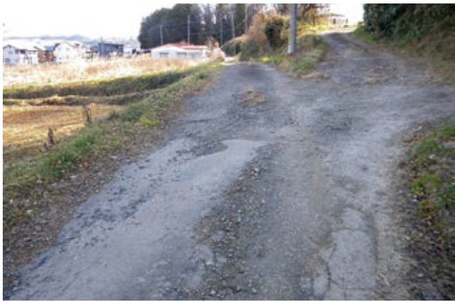
▲市道整備を市民は望んでいる。(市道万世・鍋田線)
