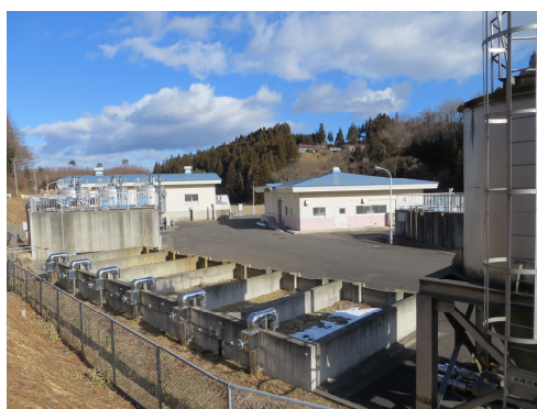
平田石浄水場
