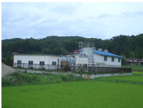
東禅寺浄水場
