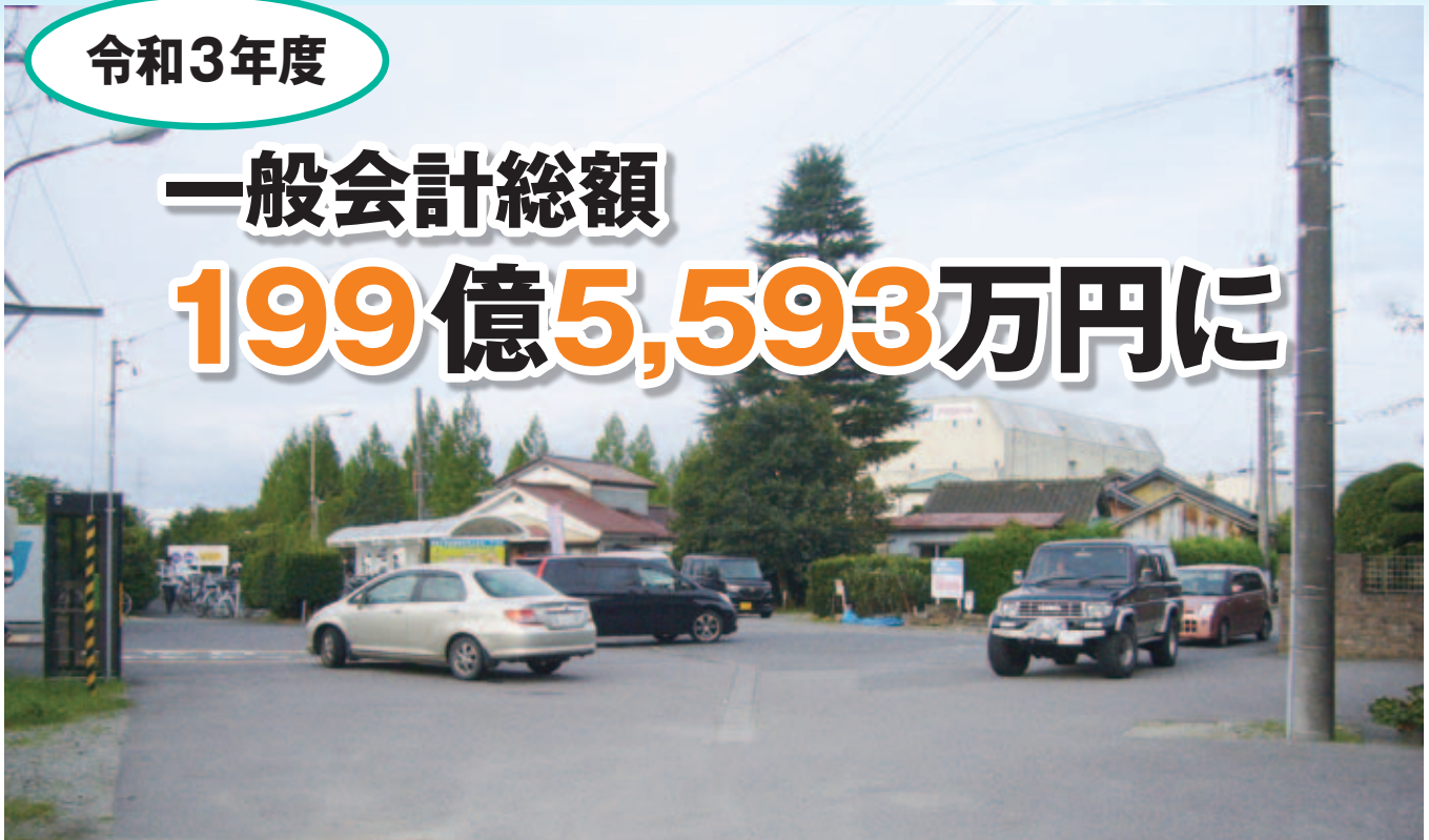
▲今後整備が進められる五百川駅前広場
