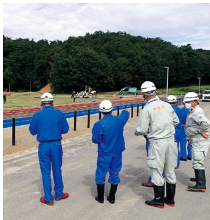
▲ランニングコース整備工事現場
