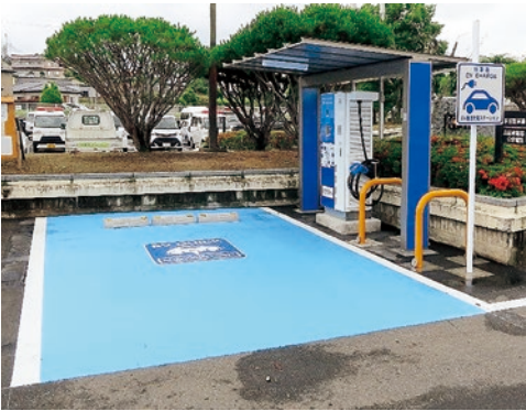
▲庁舎前に作られた電気自動車急速充電設備
