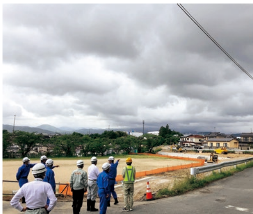
▲市道館ノ越・関根線工事箇所現地調査の様子
