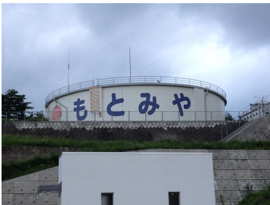
耐震化工事が完了した 立石山 PC 配水池
