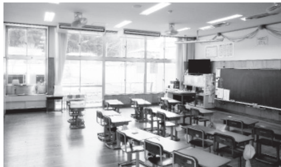
▲市内の全小中学校に設置したエアコン
