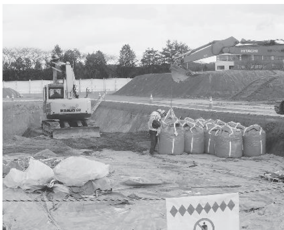
▲汚染土壌の掘り起こし現場 (白沢運動場)
