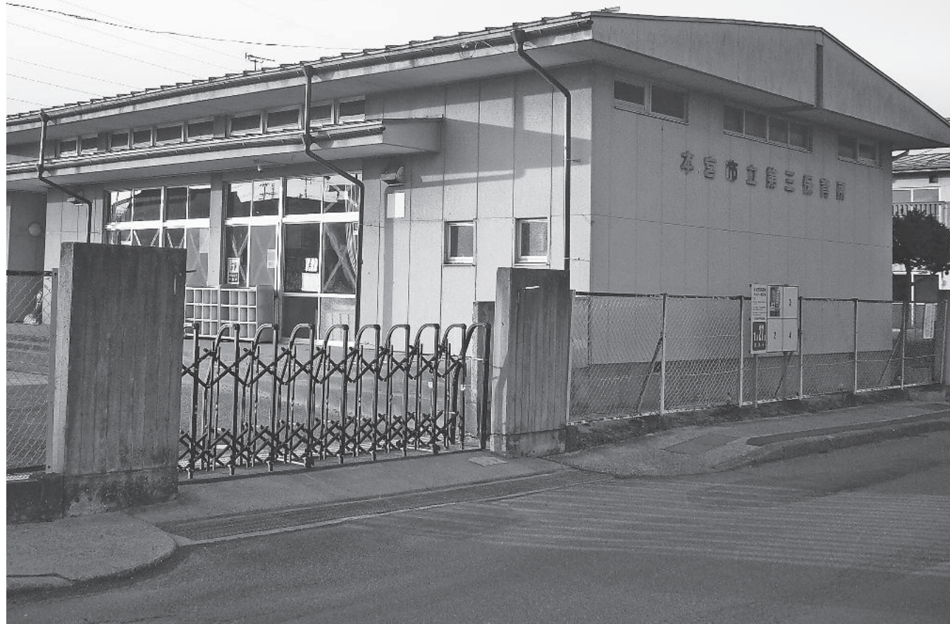
建て替えを行う本宮第3保育所
