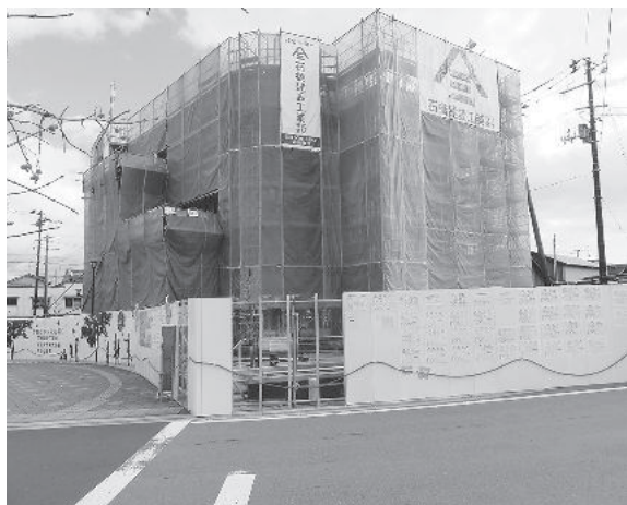
▲建設中の地域交流センター (本宮字九縄地内)
